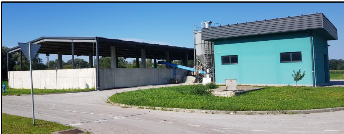
Slika 2.1-4. Zgrada u kojoj je smještena centrifuga za dehidraciju mulja (plava) i zgrada za skladištenje dehidriranog mulja
