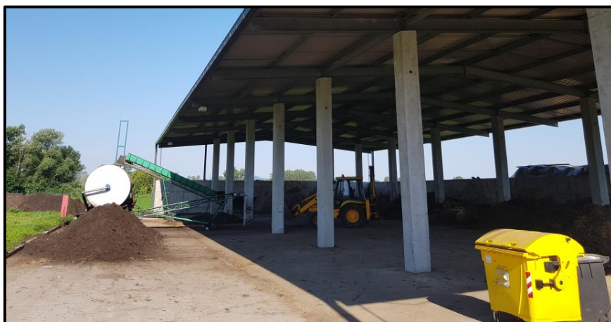
Slika 2.1-5. Zgrada za skladištenje dehidriranog mulja i biostabilizator smješten neposredno južno od zgrade
